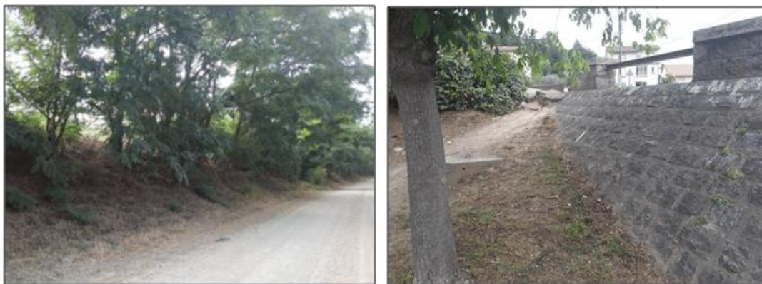
Exemples d'ouvrages étudiés dans le cadre de cette opération
