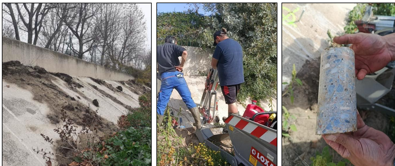
Photographies prises lors de la réalisation de sondages dans le lit de la Massane en octobre 2025
