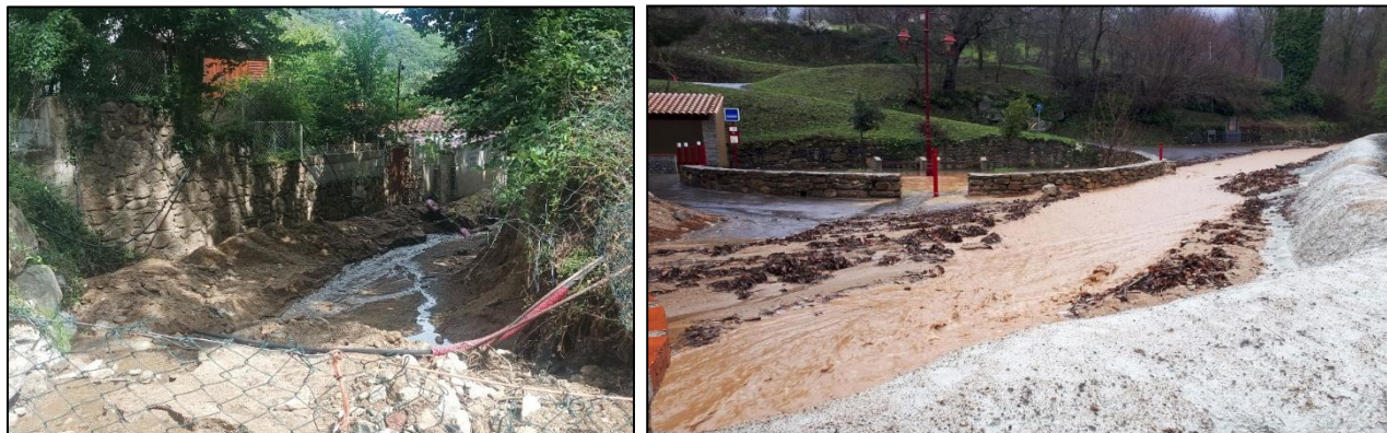
Les désordres dans la traversée du hameau de Las Illas
