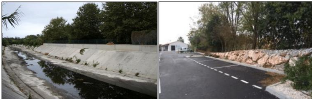
Exemples d'ouvrages étudiés dans le cadre de cette opération
