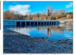
Après un an de travaux, l'ouvrage a été réouvert à la circulation d'Ortaffa.
