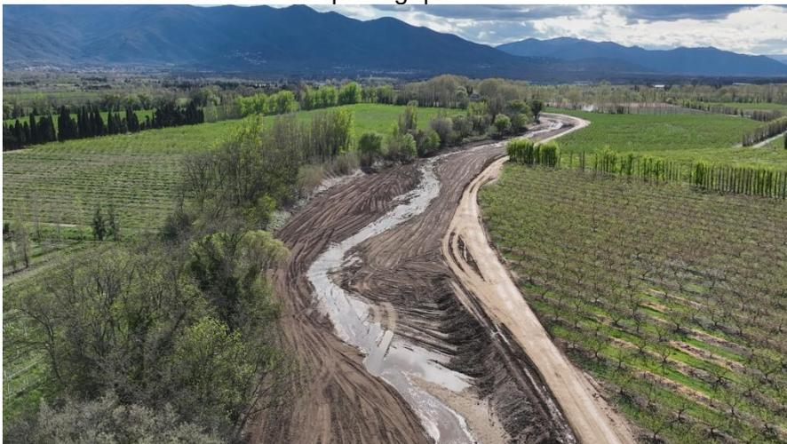
Création d'un lit emboîté et d'une sinuosité pour optimiser le fonctionnement écologique du cours d'eau
