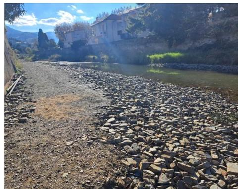
Recréation d'un lit emboîté avec risberme en rive gauche et recréation de bancs de graviers et cheminement doux en rive droite (utilisation de matériaux locaux et fraction granulométrique adaptée) © SMIGATA
