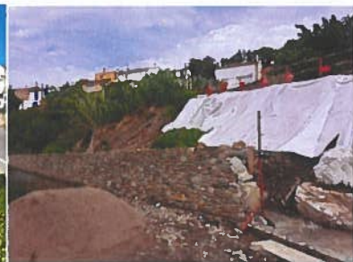
Installation du cheminement
