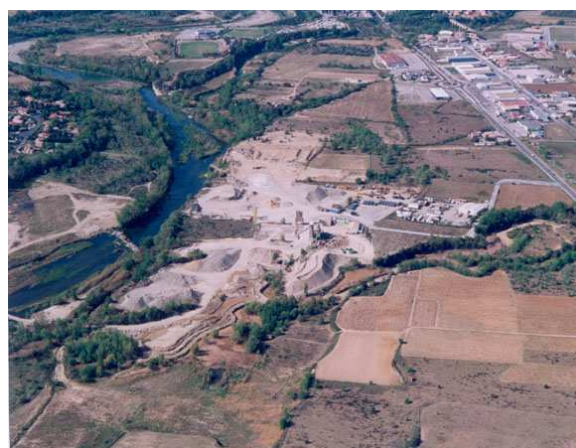
Vue aérienne du site du Boulou
