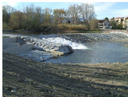
Seuil du Boulou
