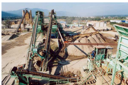
Installation de traitement des matériaux
