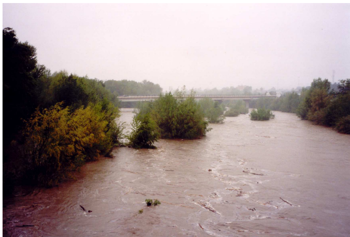
Crue en amont de la RN9 - Le Boulou avril 2002
