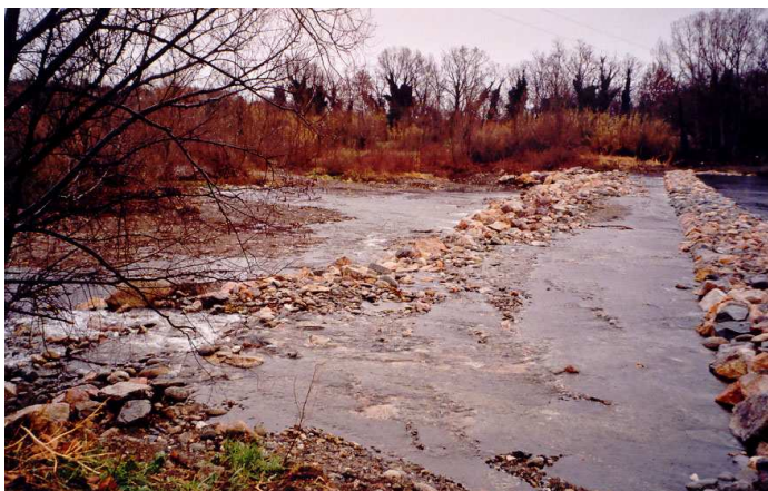
Seuil du Boulou avant travaux (vue de la rive gauche)
