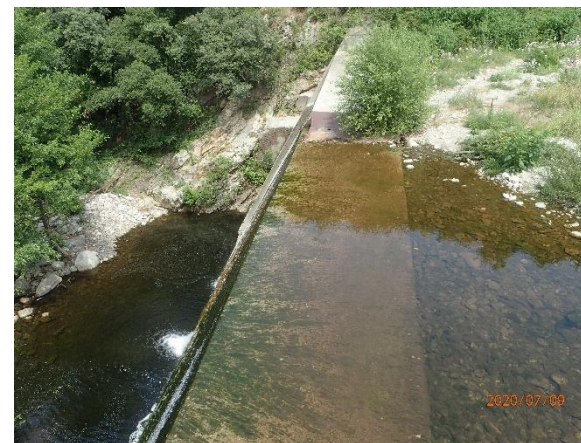
12. Seuil causant une différence de niveau topographique et de facies d'écoulement entre l'amont et l'aval
